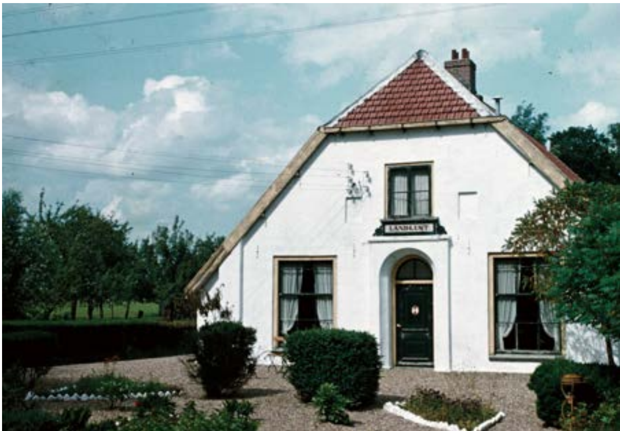
Afb. 4.19 De voorgevel van Landlust in 1954. Zeer waarschijnlijk toont de gevel de in 1854 uitgevoerde situatie naar ontwerp van N.J. Kamperdijk. De kleurstelling van het houtwerk (zand en groen) is typisch 19e-eeuws. Op de voordeur staan bescheiden de roodwit-Zuilen-kleuren (vergelijk ook met de actuele situatie, afb. 7.4). De foto geeft ook een aardig beeld van de ruimtelijkheid van Polder Buitenweg in die periode. Links (noordwest) van het gebouw ligt een boomgaard, met weiden daarachter. Het perceel van de boomgaard is tegenwoordig de scheidingssloot tussen Landlust en de tennisvereniging. Foto juni 1954, HUA, cat.nr 22058.
