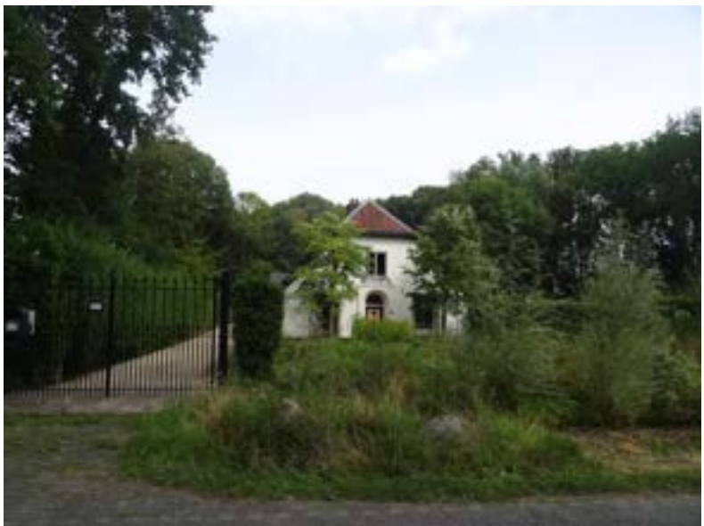
Afb. 7.4 De entree en voorgevel van Landlust, vanaf de 2e Polderweg. In de gevel is de kleurstelling van het houtwerk (sterk) veranderd ten opzichte van de situatie in 1954 (afb. 4.19). De boerderij heeft hierdoor aan levendige uitstraling ingeboet.
