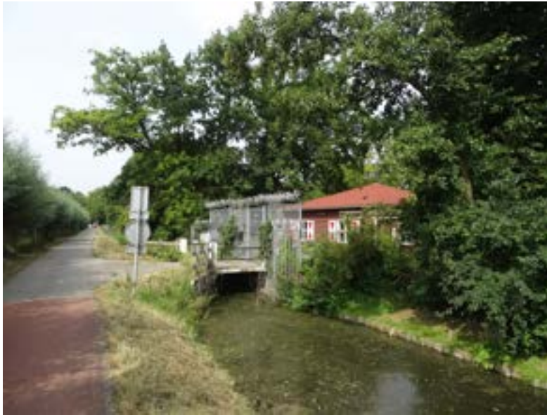
Afb. 6.11 De 2e Polderweg wordt geflankeerd door sloten. Langs de noordzijde ligt een brede sloot (foto). Aan de zuidzijde ligt een smalle sloot. De brede sloot is een oude afwatering van de polder Buitenweg.
