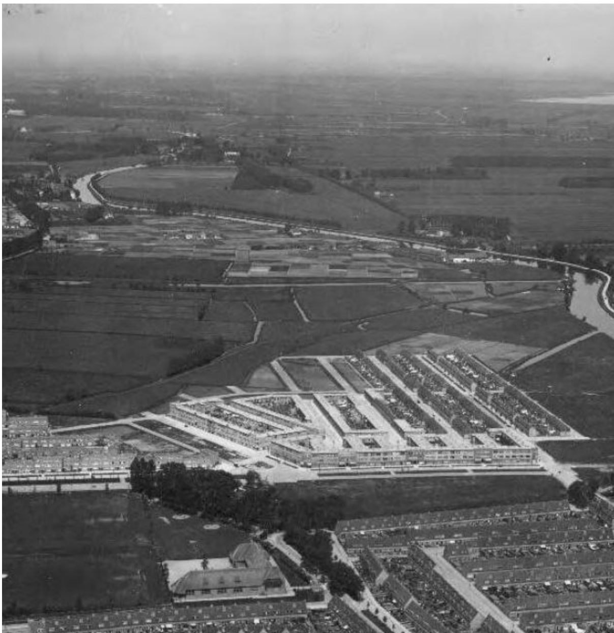
Afb. 2.17 Vogelvluchtfoto uit de periode 1920-30 van boven de wijk Ondiep, met op de achtergrond het plangebied in de bocht van de Vecht. Tussen de agrarische percelen ligt het jonge wandelbos met de Iepenlaan. De omwandeling tussen Vechtdijk en de Grote akker is nog niet aangelegd. Langs de oever staat een boomrij. Detail van foto, HUA, cat.nr 84637.
